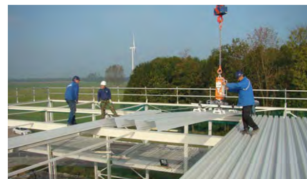
CladBoy CB5 - den praktiske enhed for vægpaneler. Også egnet til højprofiler/tagpaneler. Konfigureres efter opgave.
