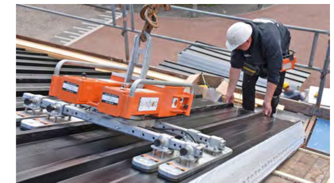
Kompakt 4 Flex - med justerbare, specielt formede sugeskopper for montering af en bred vifte af profilerede paneler.
