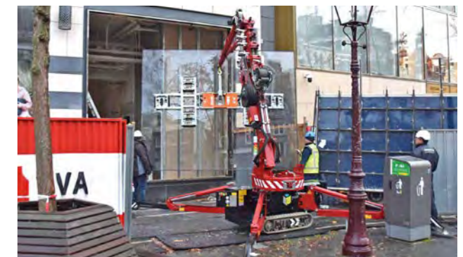
GBXL - allround maskine til montering af de fleste glasstørrelser op til 1000 kg.
